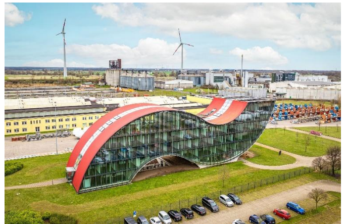
Im Rahmen von Flächenoptimierungen mietet SIKOSA über Aengevelt 3.570 m 2 Bürofläche in der „Sinuskurve“ © Aengevelt Immobilien GmbH & Co. KG
