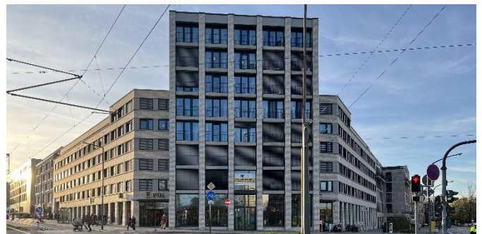
Repräsentatives Bürogebäude in Dresden. © Aengevelt Immobilien GmbH & Co. KG
