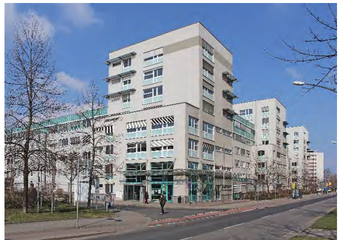
Mit einem der größten Einzelabschlüsse 2015 mietet das Jobcenter Dresden eine Bürofläche von fast 25.000 m 2 nebst 244 Stellplätzen im Büro- und Verwaltungsgebäude in der Budapester Straße 30. © Foto: AENGEVELT
