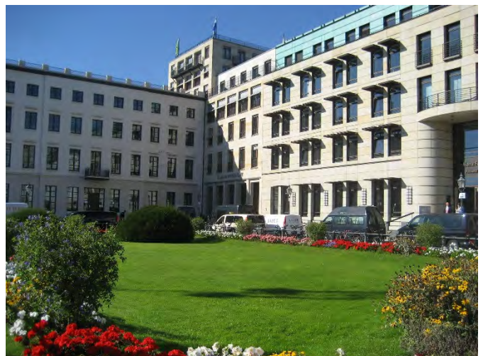
Am Pariser Platz direkt neben dem Brandenburger Tor erzielte das Bürovermietungsteam von AENGEVELT-IMMOBILIEN 2015 die vermutete Maximalmiete für Büros in Berlin. © Foto: AENGEVELT
