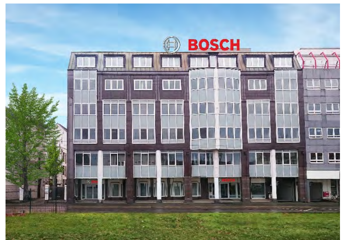
Bosch Service Solutions startet ein Servicecenter mit 200 Mitarbeitern und mietet 6.600 m 2 Bürofläche von der Leipziger Stadtbau mit Vermittlung durch AENGEVELT. © Foto: AENGEVELT
