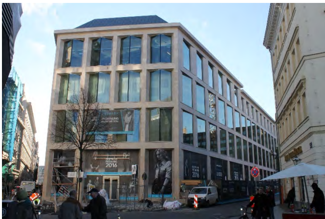
Hoffnungsträger Hainspitze: Mit dem Zugpferd Primark wird die 1a-Meile von Petersstraße über Markt und Hainstraße in die Höfe am Brühl und weiter zum Hauptbahnhof konzeptionell unterbrechungsfrei geführt. © Foto: AENGEVELT
