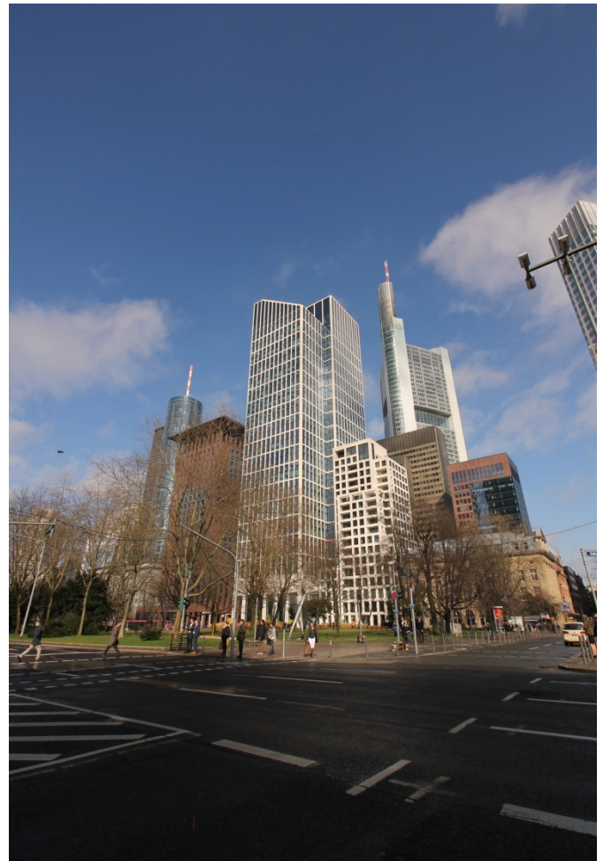
Das "Taunusturm-Ensemble" im Frankfurter Bankenviertel besteht aus einem 40-stöckigen und 170 m hohen Büroturm sowie einem 63 m hohen Wohngebäude. Der Verkaufspreis wird mit rd. EUR 650 Mio. taxiert.
